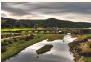
Puente sobre el río Almonte
