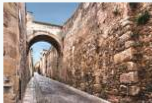
Muralla en la calle Adarve de la Estrella
