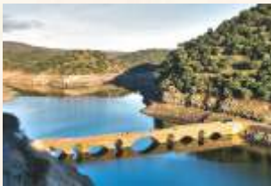
Puente del Cardenal
